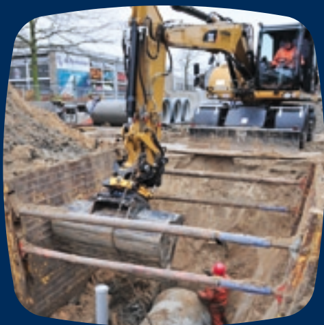
Aanleg riolering op 3,5 meter diepte
