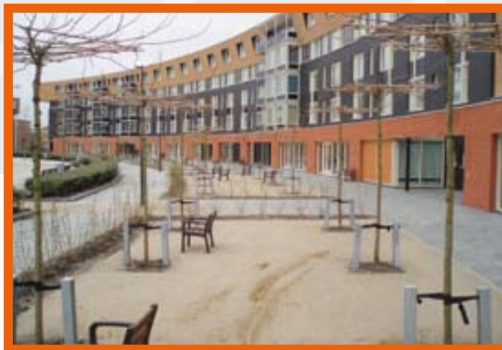
■ Cruquius Plaza in aanbouw
